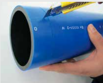
С ножче направете перпендикулярен разрез на повърхността на слоя.
