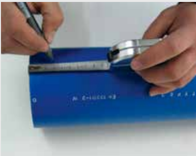
Измерване и маркиране на тръбата;
